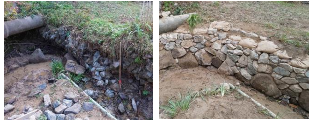
写真-2 着工前(11月25日) 写真-3 竣工(12月16日)
